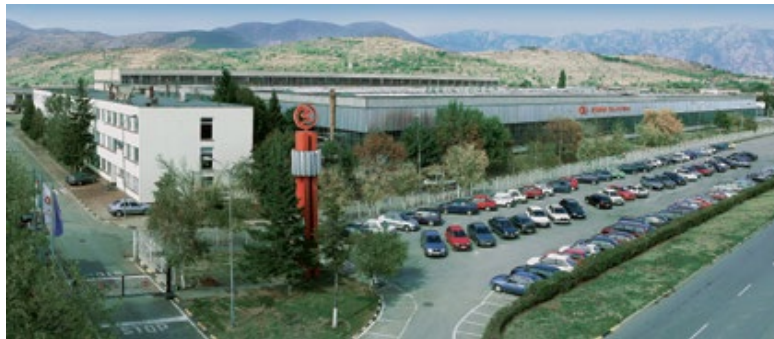
ZMM Sliven production plant
